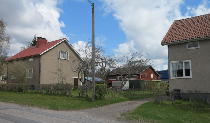
Näkymä Lehtolankadulta. Puuverhouksen ohella käytettiin jälleenrakennuskauden pientaloissa myös yleisesti vaaleaa hieman ruskeaan taittuvaa rois-kerappausta. Vasemmanpuoleisessa rakennuksessa näkyy aikakauteen liittyvänä modernina yksityiskohtana nurkkaikkuna, joka uudella tavoin avasi näkymiä ja toi valoa asuntoihin. Tonttien takaasaan rakennettiin talousrakennukset usein neljän tontin yhteisinä kokonaisuuksina. Modernin rakennustyylin vastakohtana saatettiin näissä toteuttaa perinteisiä rakennustapoja ja yksityiskohtia. Sekä Kannaksen että Polarin alueilla esiintyy tällaisia mm luhtiaitoiksi rakennettuja talousrakennuksia.
