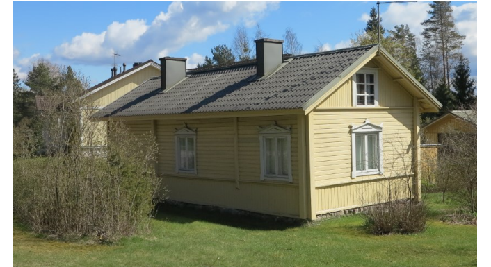
Nyhkäläntie 18 1800-luvun asuinrakennus
