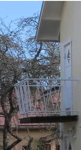
Karkkilan jälleenrakennuskauden pientaloissa esiintyy yleisesti kauniina yksityiskohtina kaipa pystypaneeli ja ulokeparvekkeet koristeellisine teräskaiteineen.
