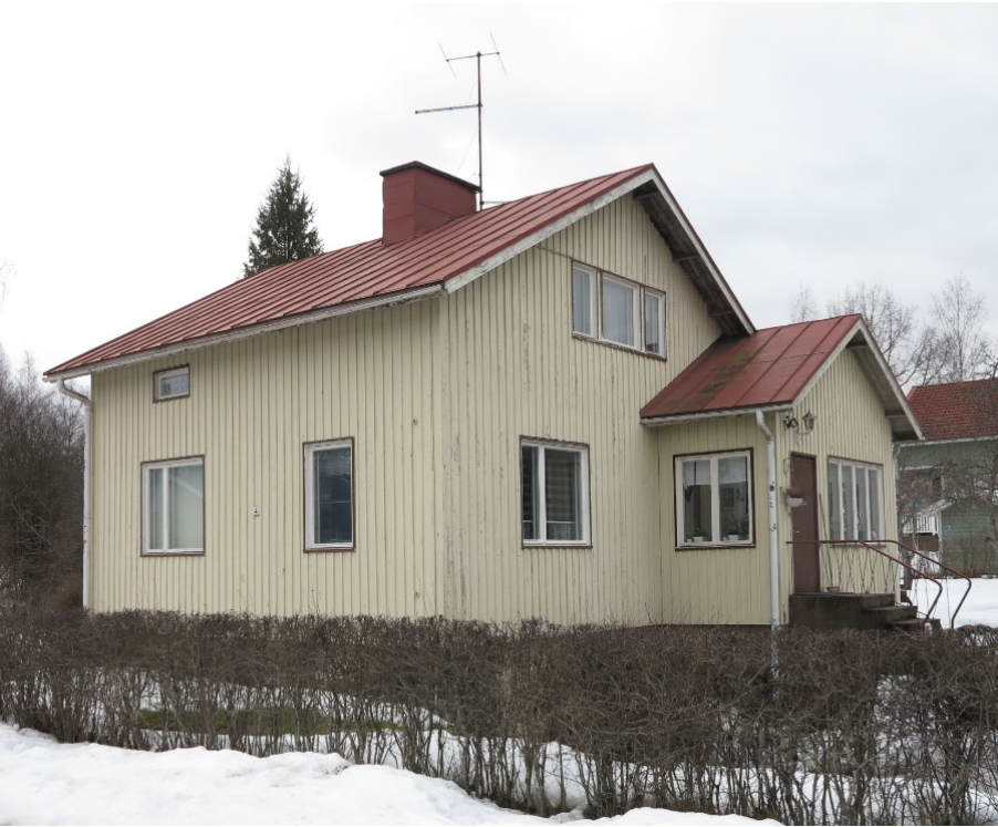
Asuntovaliokunnan tyyppitalo A5 osoitteessa Vilhelminkatu 4 on hyvin säilyttännyt alkuperäiset piirteensä, johon liittyy pystyrimavuoraus, pystyjakoiset puuikkunat tehostesävyisine ohuine vuorilistoineen. Kuisti on saatettu rakentaa umpeen jo alkuun tai pian sen jälkeen. Portaisiin liittyy aikakaudelle tyypilliset teräskaitteet.
