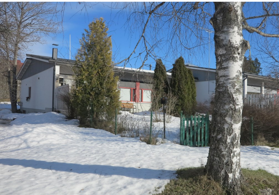
Äyrästien eteläreunan kortteliin 28 valmistui vuonna 1971 porrastuvasta rakennusmas- sasta muodostuva, alkujaan tasakattainen rivitalo. Talon suunnitteli arkkitehti Erich von Ungern- Sternberg, joka myös laati alueen 1970 vahvistuneen asemakaavamuutoksen. Asuntoja erottavat julkisivusta ulkonevat palomuurit muodostavat julkisivuaiheen. Ikku- nat on ryhmitelty nauha- ja kenttämaisiksi kokonaisuuksiksi. Japanilaisvaikuteista il- mettä luo julkisivujen harmaa ja valkoinen pääsävy, sekä punainen ja musta tehostesävy. Rakennuksiin myöhemmin tehtyt pulpettikatot ovat muuttaneet alkuperäistä ilmettä.
