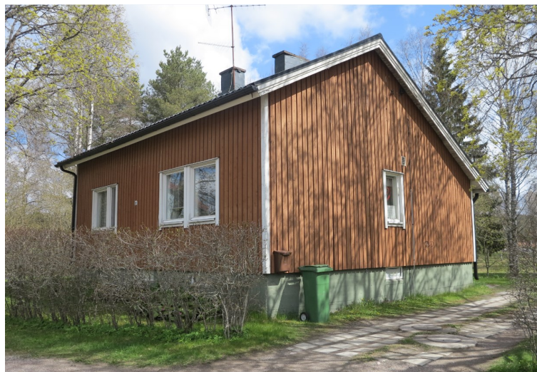
Puutalo Oy:n Högforssin talotyyppi. Korvenkatu 19
