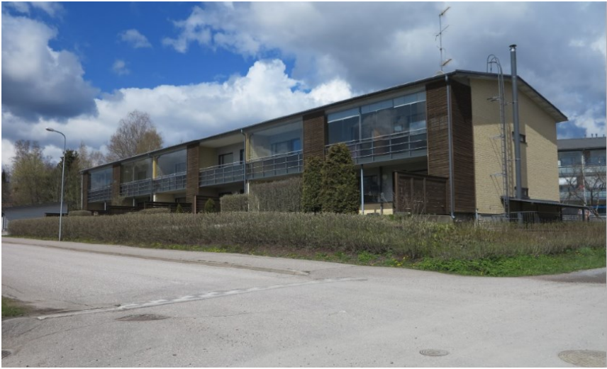
Rajakatu 11-13 kaksikerroksinen rivitalo rakennettiin 2010-luvulla.
