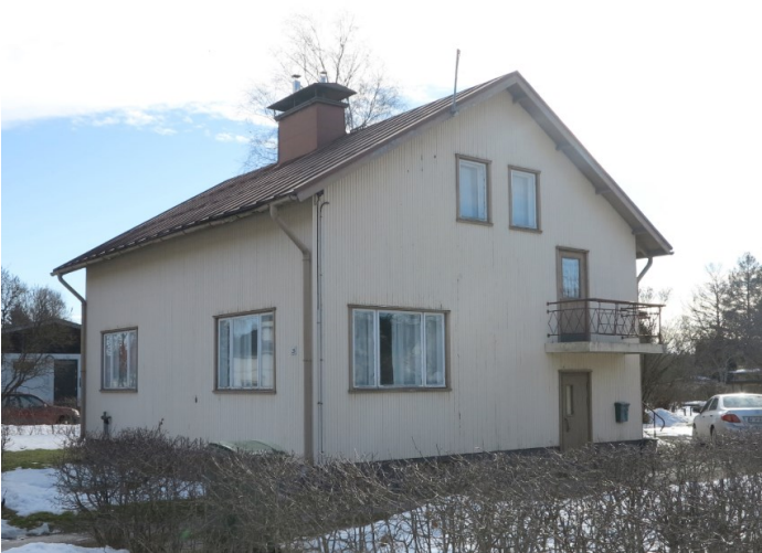
Huoltoasemanhoitaja Torsten Silva`nin Huvilakatu 26:teen rakennuttaman 1955 valmistuneen talon suunnitelmat laati rakennusmestari Olavi Lahti. Rakennuksen julkisivuissa on säilynyt vanha kapea pystypaneeli ja alkuperäiset ikkunat.
