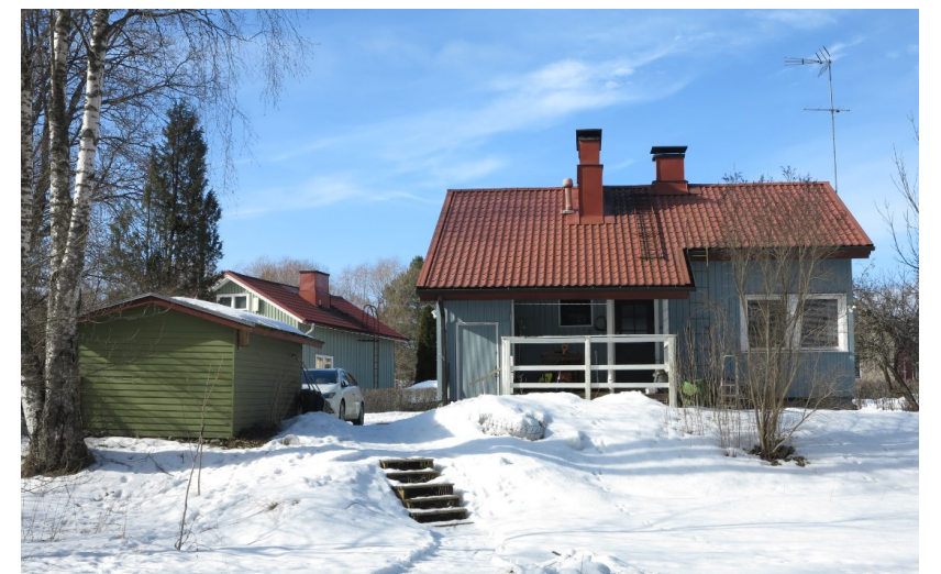
Puutalo Oy:n Högforssin talotyyppi. Korvenkatu 21
