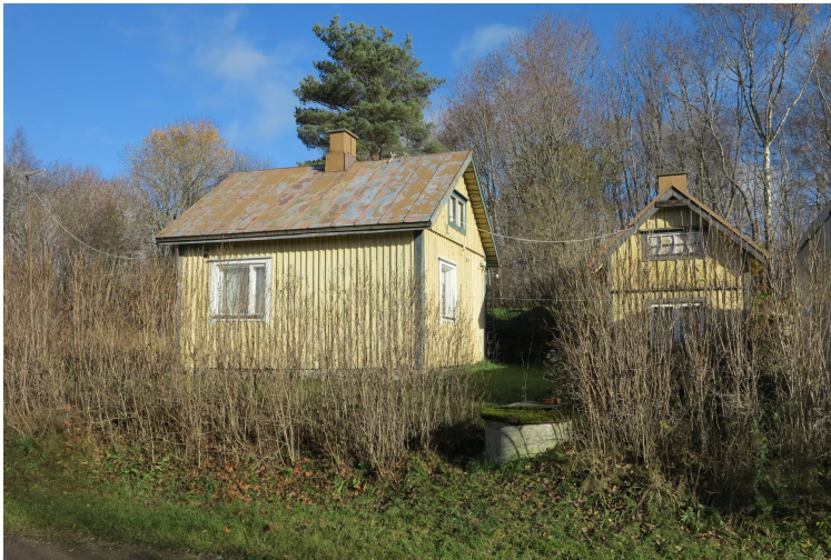
Vanhalla kylätontilla mäenrinteessä on säilynyt vanhempi, mahdollisesti 1900-luvun alussa rakennettu pienehkö luonnonkivisokkelille perustettu mökki talousrakennuksineen. Ikkunat ovat tyyliltään 1950-luvulta.
