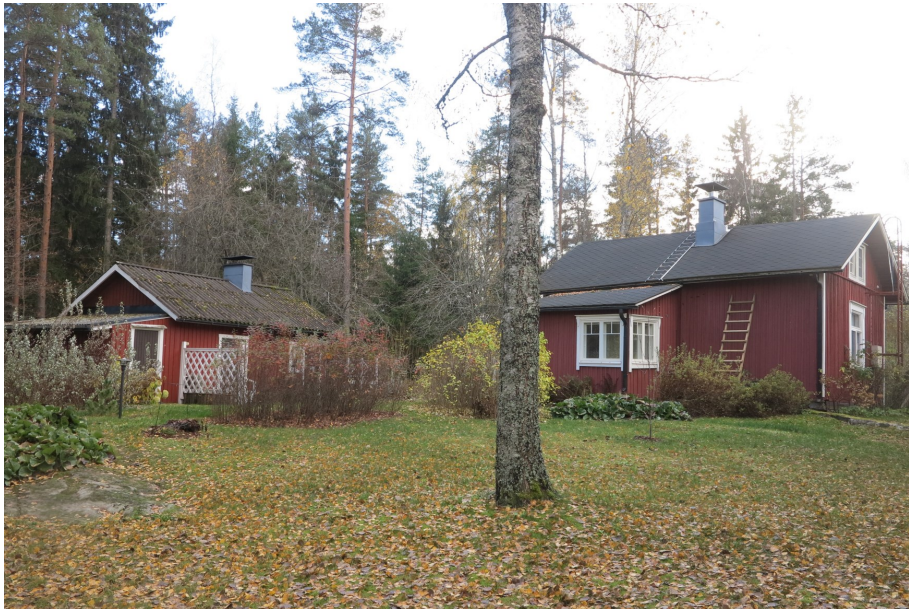
Renbackan paikaksi kutsuttu tuvan ja huoneen mökki on rakennettu vuonna 1905 Mäkilän tilan maalle. Se on aikanaan sijainnut kylän reunamalla metsän keskellä, ja siinä on asunut metsänvartija Nyholm, joka mahdollisesti on talon rakentanutkin.
