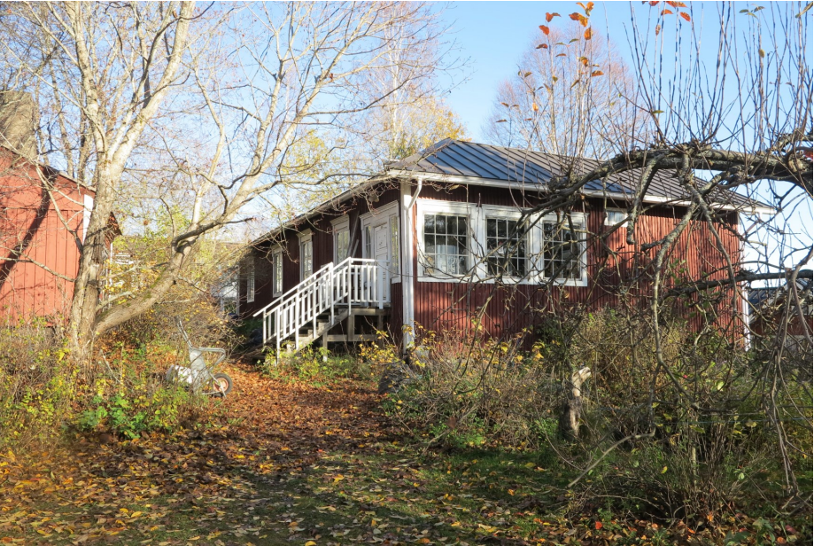
Oletettavasti 1800- 1900-lukujen vaihteessa rakennetussa talossa on toiminut paikakakunnan ensimmäinen puhelinkeskus vuodesta 1907 1930-luvulle saakka. Keskuk- sen pitäjänä toimi tuolloin talossa asunut kultaseppä Gustafsson vaimoineen. Sa- manaikaisesti ja vielä viime sotien jälkeen toimi rakennuksessa Juseliuksen kaupp- aliike ja jonkin aikaa myös kahvila. Kauppa sijaitsi rakennuksen eteläpuolelle myö- hemmin tehdyssä laajennuksessa. Kerrotaan myös että rakennuksessa olisi I maail- mansodan aikana toiminut kansankeittiö linnoitustöissä olleille.
